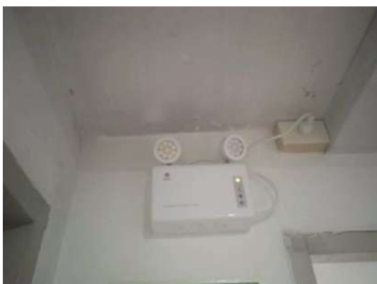
ภาพที่ 11 ไฟส่องสว่างฉุกเฉิน
